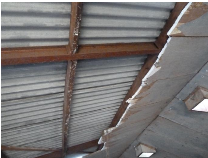
Detail binnenzijde dak te slopen varkensstal
