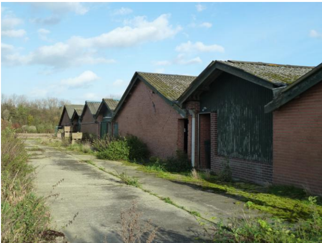
Te slopen varkensstallen
